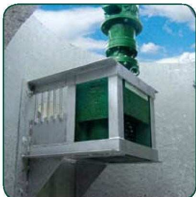
Mini Monster installée dans une station de pompage
